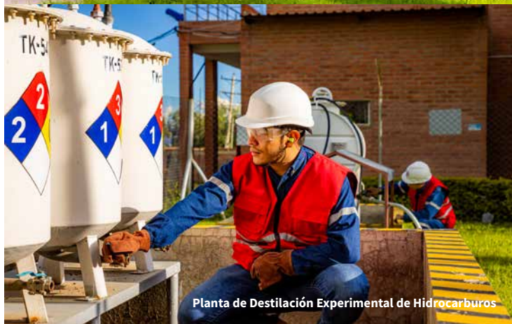
Planta de Destilación Experimental de Hidrocarburos
